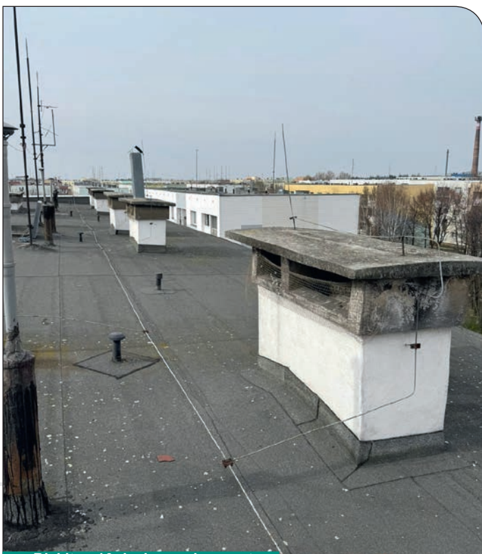
os. Błękitne 16 dach przed remontem
